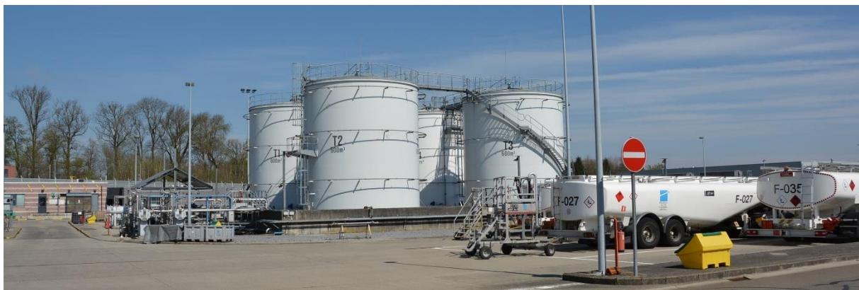
Figure 10 : Vue sur le parc pétrolier, en zone nord (ARIES, 2023)
