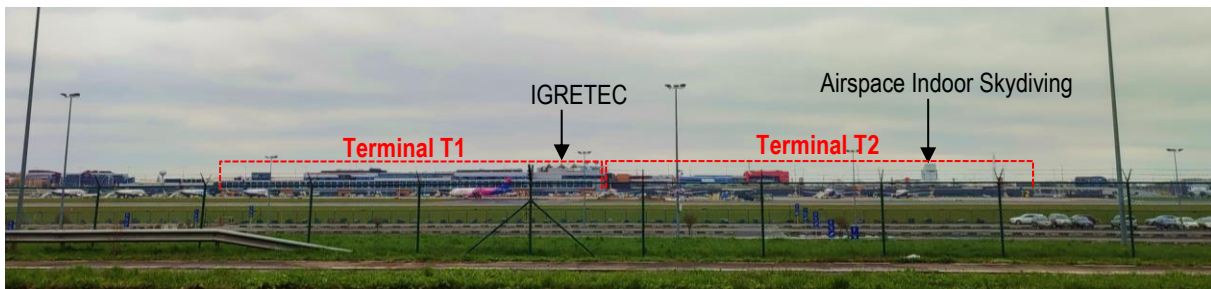
Figure 24 : Vue sur le site aéroportuaire depuis la rue de Ransart au niveau du parking P3 (ARIES, 2023)
