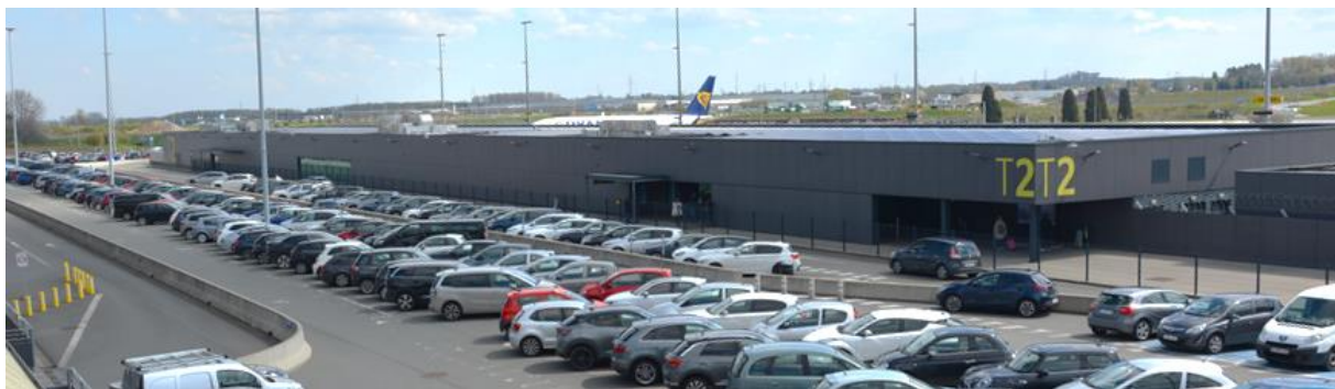
Figure 7 : Vue sur le T2 depuis le parking Express (ARIES, 2023)
